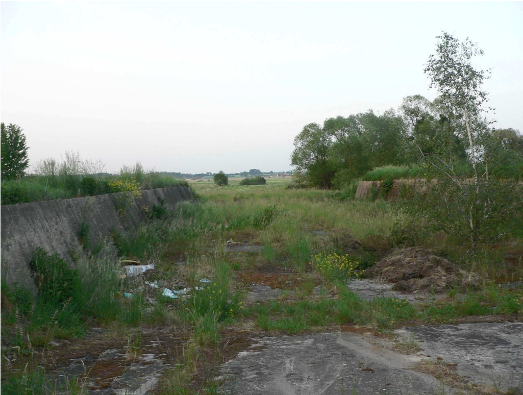
Teren inwestycji-objekty porolnicze w postaci płyt obornikowych (obiekt nr2)
