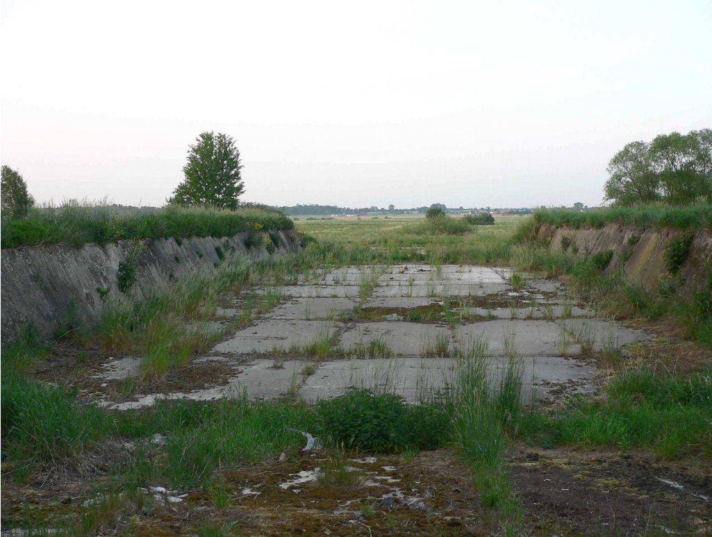
Teren inwestycji-objekty porolnicze w postaci płyt obornikowych (obiekt nr1)
