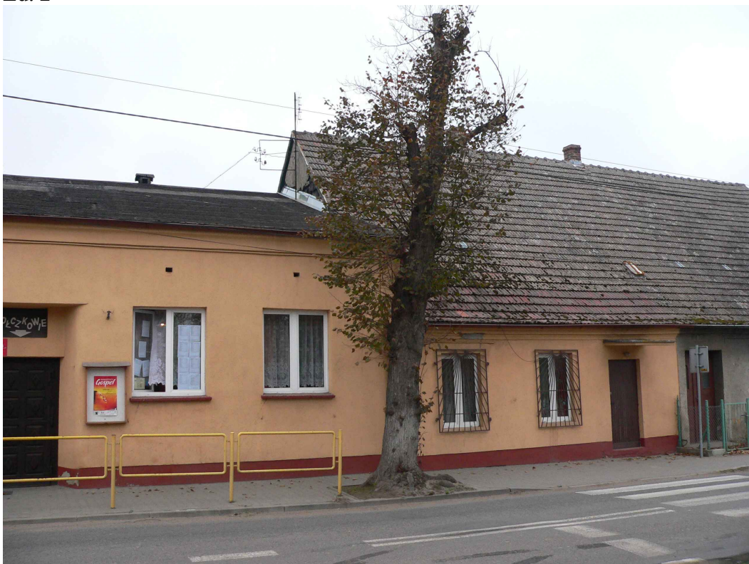
Widok elewacji frontowej od strony ulicy Lipowej (część klubu zlokalizowana w budynku sąsiednim)
