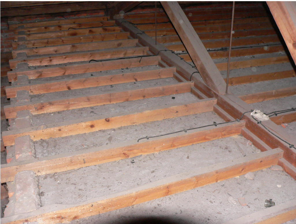
Poddasze-widok konstrukcji stropu nad salą ogólną
