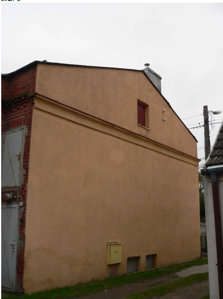
Widok elewacji szczytowej (od strony przejazdu)
