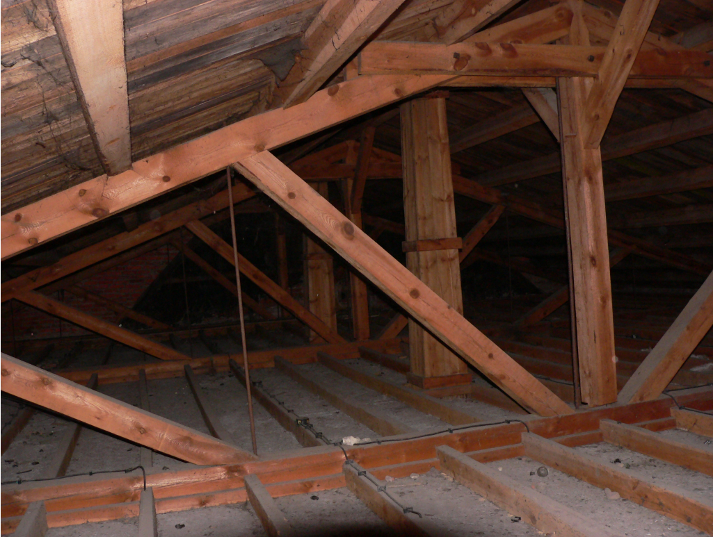
Poddasze-widok głównej konstrukcji dachu (drewniane wiązary kratowe)
