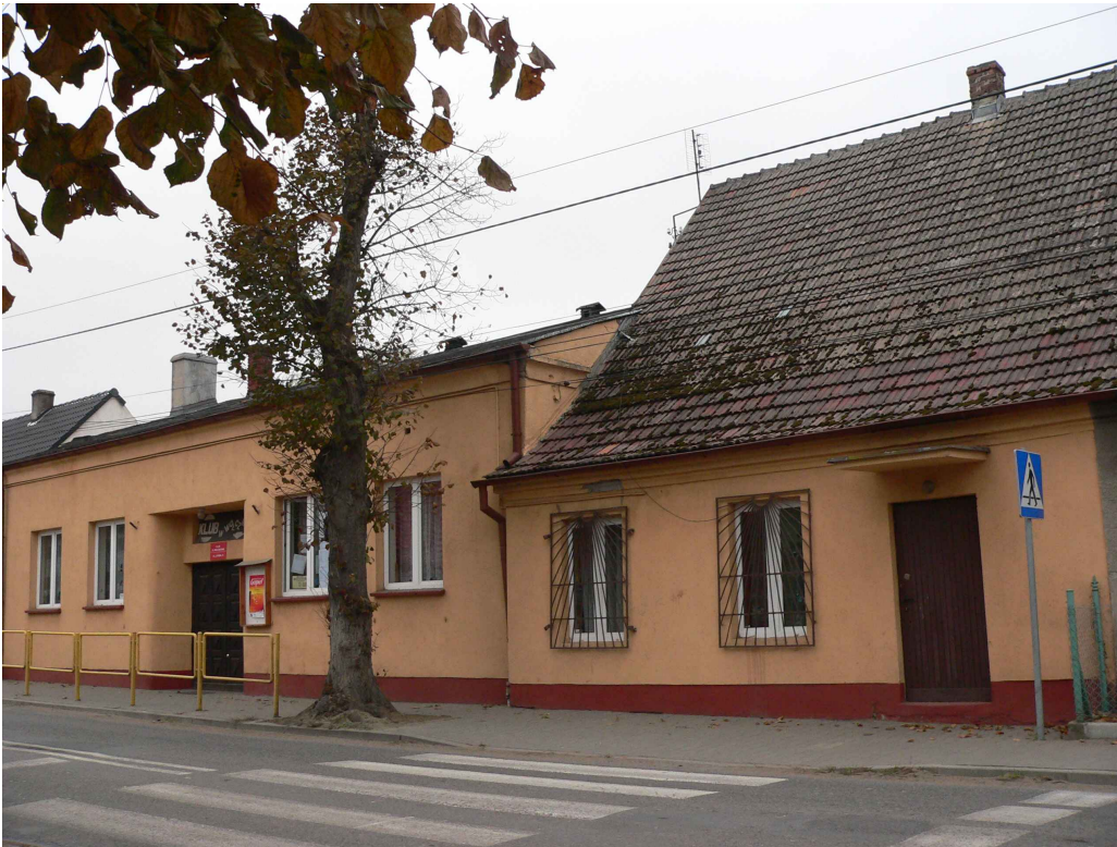
Widok elewacji frontowej od strony ul. Lipowej (wejście boczne od strony budynku sąsiedniego) Zd. 3
