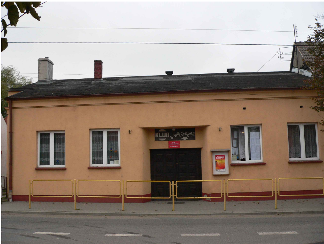
Widok elewacji frontowej od strony ulicy Lipowej (wejście główne)
