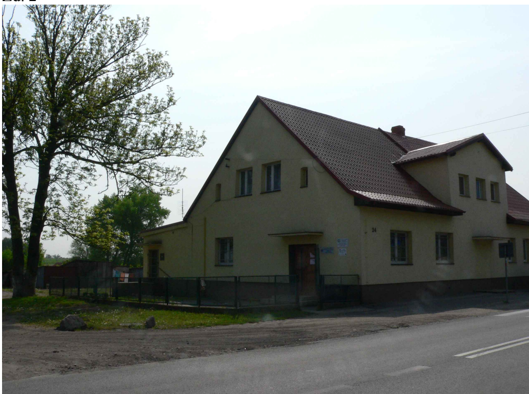
Widok budynku od strony północno-zachodniej (wejście główne) c.d.
