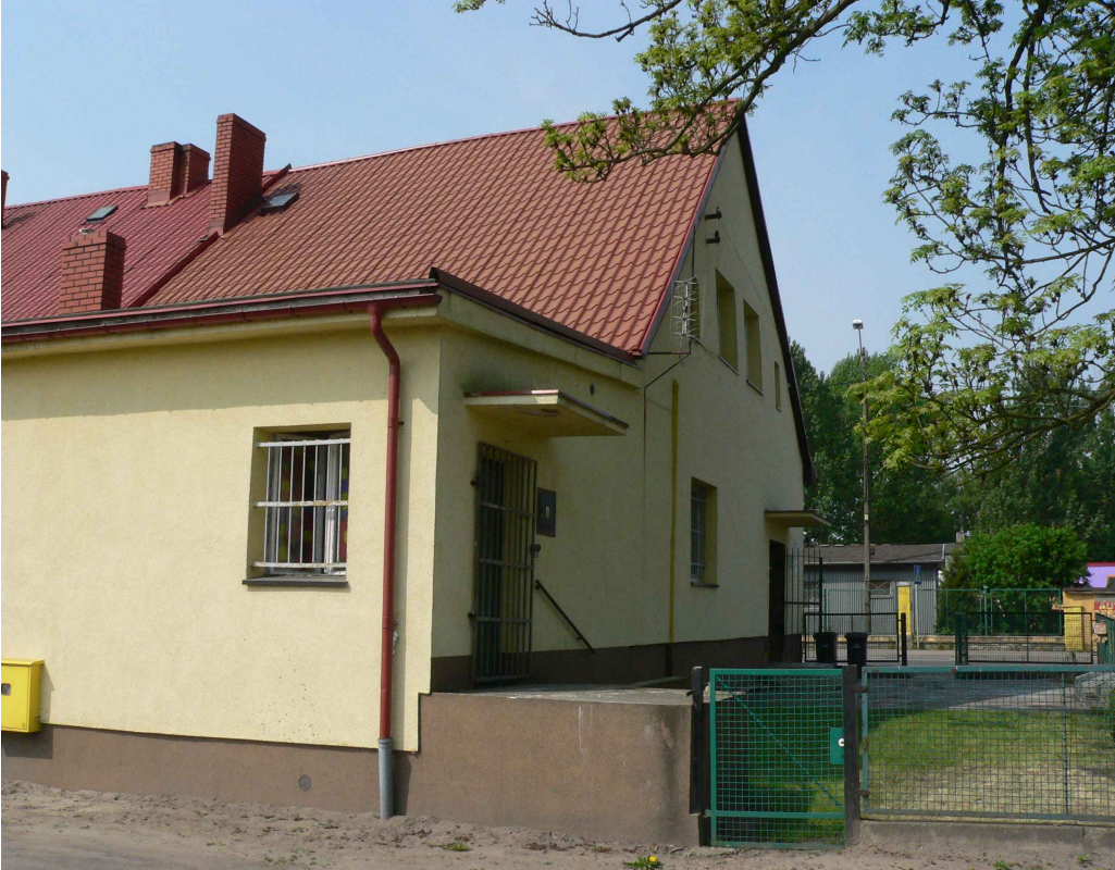
Widok budynku od strony północno-wschodniej
