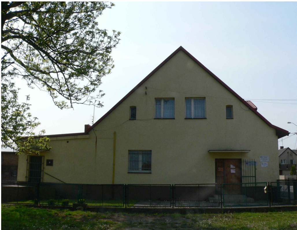
Widok elewacji północnej (wejście główne)
