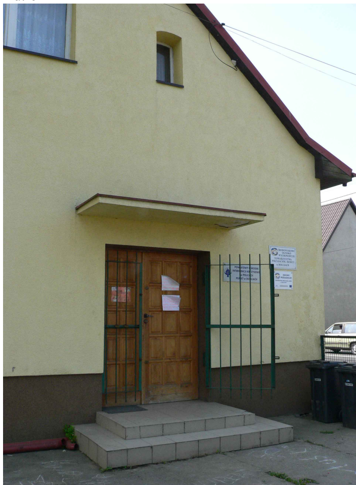
Widok elewacji północnej (wejście główne)
