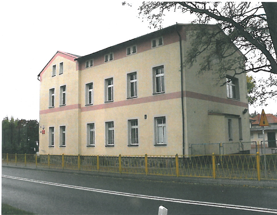
Elewacja północna – od strony ul. Weleckiej
