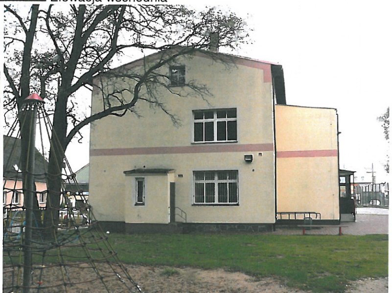
Elewacje południowo-zachodnia i zachodnia: w elewacji zachodniej przedsionek dodatkowego wyjścia z sali nr 1 w elewacji południowej ryzalit głównej klatki schodowej przekryty płaskim stropodachem.
