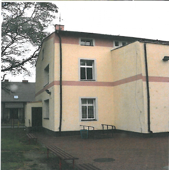
Elewacje południowo-zachodnia i zachodnia: w elewacji zachodniej przedsionek dodatkowego wyjścia z sali nr 1 w elewacji południowej ryzalit głównej klatki schodowej przekryty płaskim stropodachem.
