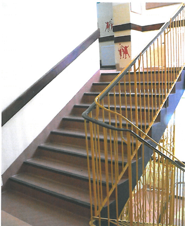
Klatka schodowa: bieg na piętro i podest piętra
