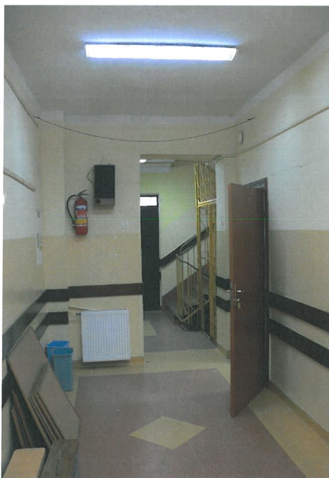
Korytarz na parterze – widok w stronę klatki schodowej
