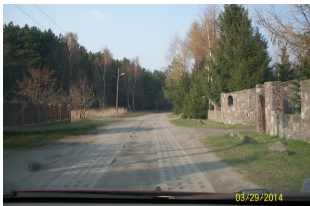
Fot. 2. Ul. Leśna – widok w kier. północnym
