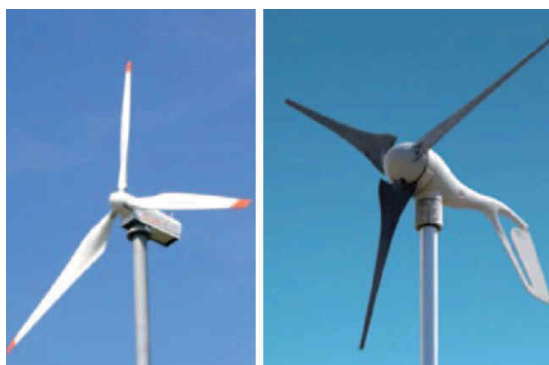
Rysunek 18 Turbiny o poziomej osi obrotu 184
