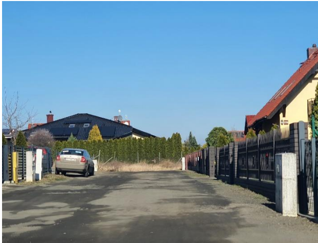
Mierzyn ul. Nasienna – sięgacz przed wykonaniem prac
