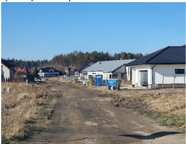
Kościno ul. Żurawia przed wykonaniem prac
