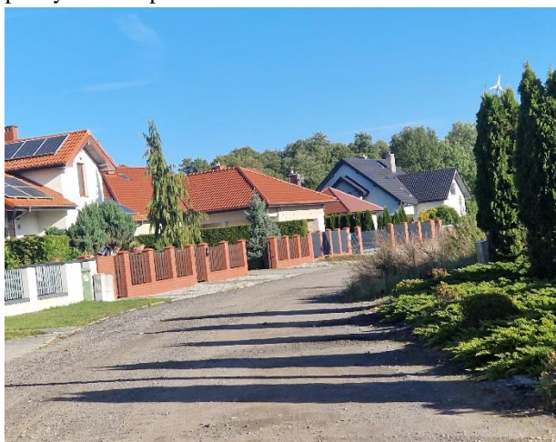
po wykonaniu prac
