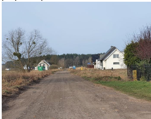
po wykonaniu prac
