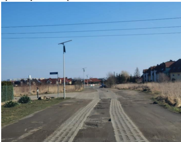
Mierzyn, ul. Komercyjna przed wykonaniem prac
