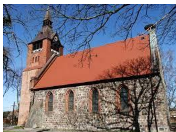
Wymiana zdegradowanych przeszkleń okiennych w kościele w Wołczkowie – III etap – w kwocie 40 000 zł.
