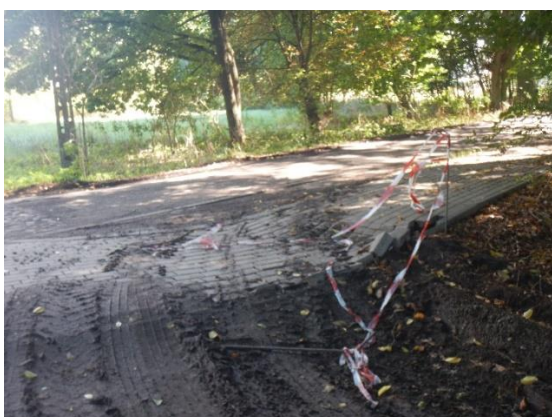
Uszkodzenie części chodnika, w wyniku interwencji chodnik naprawiono.
