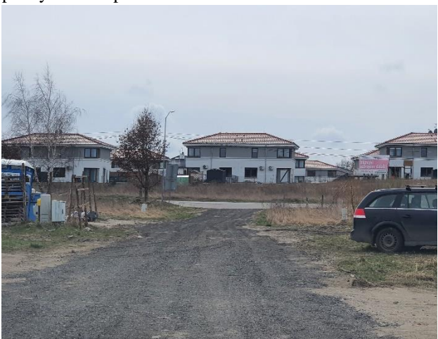
po wykonaniu prac
