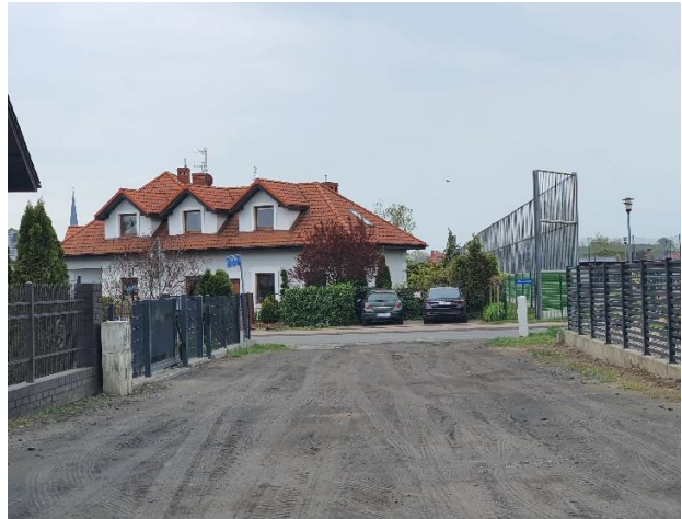
po wykonaniu prac
