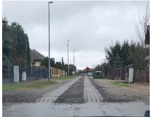
po wykonaniu prac
