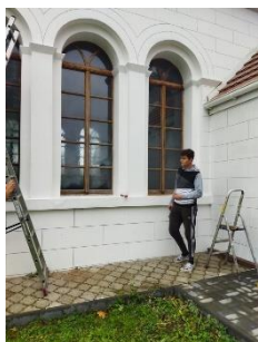
Remont stolarki okiennej i drzwiowej kościoła filialnego p.w. MB Fatimskiej w Kościnie – w kwocie 40 000 zł.
