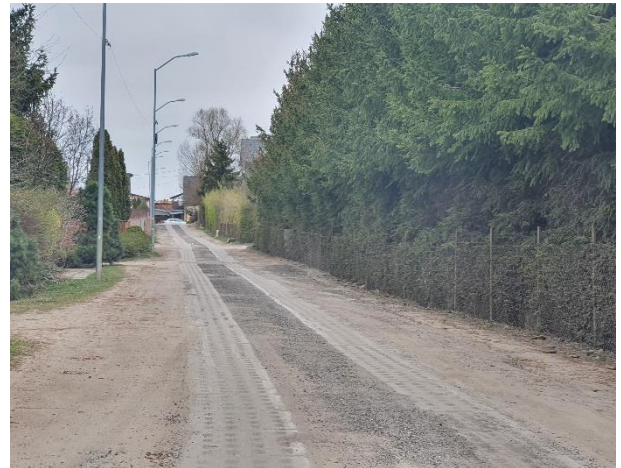
po wykonaniu prac
