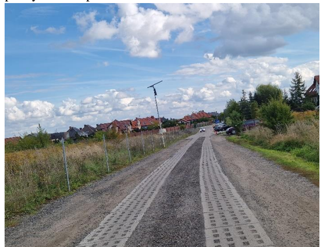
po wykonaniu prac
