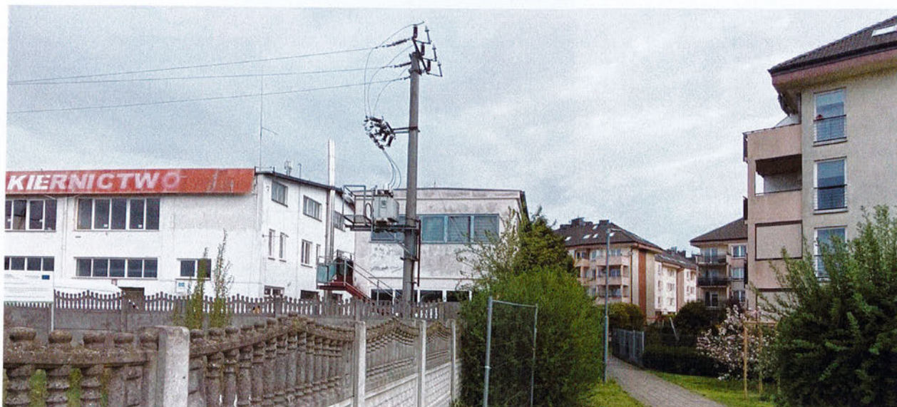
Nieszczerólnie korzystne sąsiedztwo istniejącego zakładu obsługi pojazdów CEMOT (blacharstwo, serwis samochodowy) dla zabudowy mieszkaniowej osiedla Za Sterem
