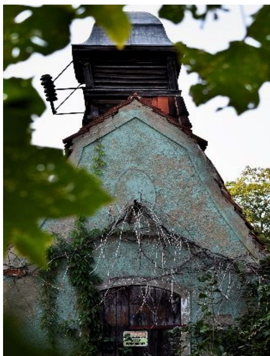
Fot. 2. Fotografia przedstawiająca Remizę – Trafostację w Stolcu – I miejsce w konkursie fotograficznym pn. „Zabytki Gminy Dobra w obiektywie” w 2024 r. Autor: K. Chomiuk.
